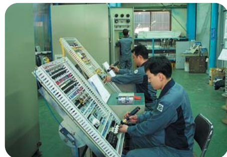
▶ 제어반 속판작업 (Control Panel Mfg.)
