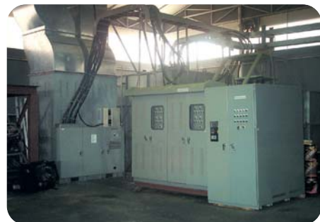
▶ 저항 부하 및 리액타 부하 설비 (Resistive & Reactive Load Banks)
